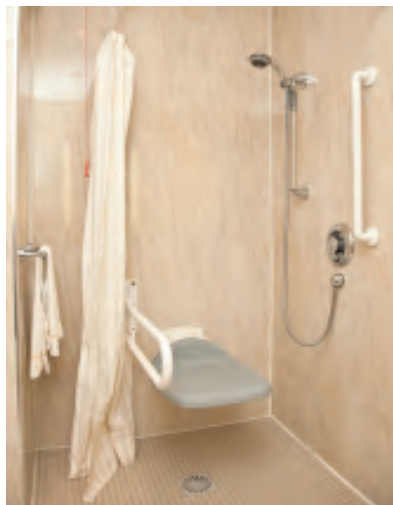
Slika 21. Fotografija (lijevo) prikazuje pristupačni prostor za tuširanje s vodootpornim preklopnim sjedalom, držačem za ruke i alarmnim uređajem ( http://jordanbuildersandjoiners.co.uk/disabled-access/ ), a prikaz (desno) prikazuje nacrt pristupačnog prostora za tuširanje ( http://www.bibliocad.com/library/disables-washbasin_32033 ).
